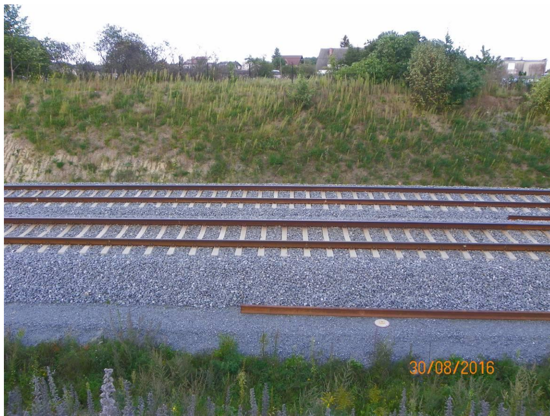
Ryc. 36 – Stan torowiska na odcinku badawczym, przy którym zlokalizowano punkt P02R
