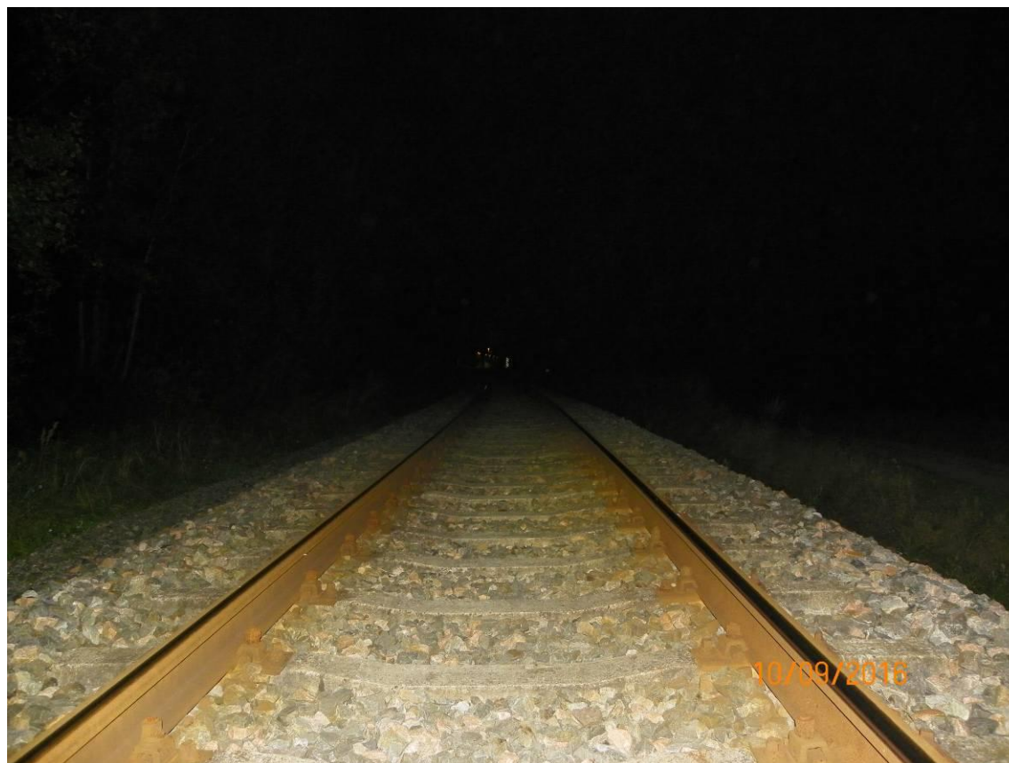
Ryc. 42 – Stan torowiska na odcinku badawczym, przy którym zlokalizowano punkt P04R
