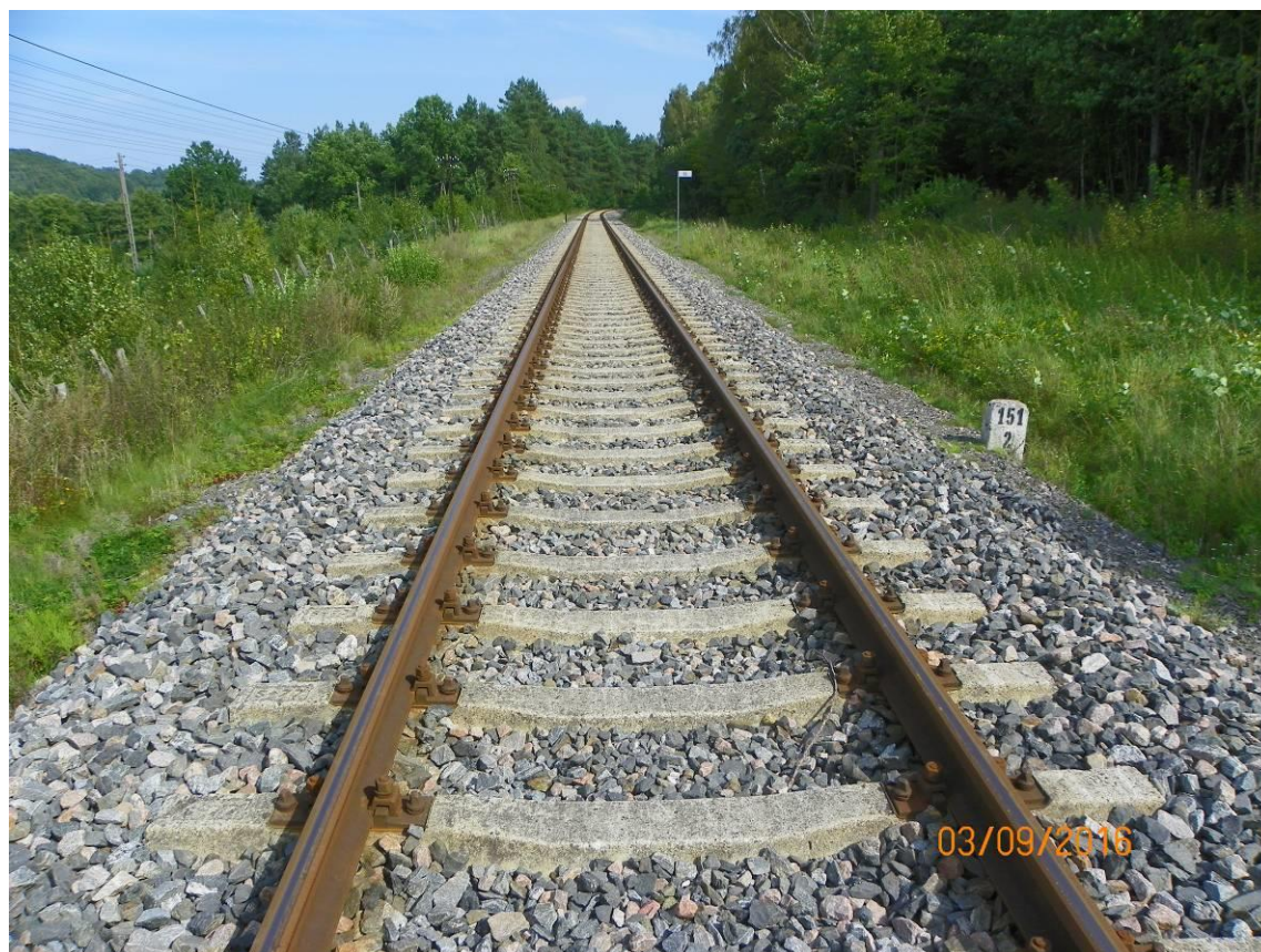
Ryc. 45 – Stan torowiska na odcinku badawczym, przy którym zlokalizowano punkt P05R
